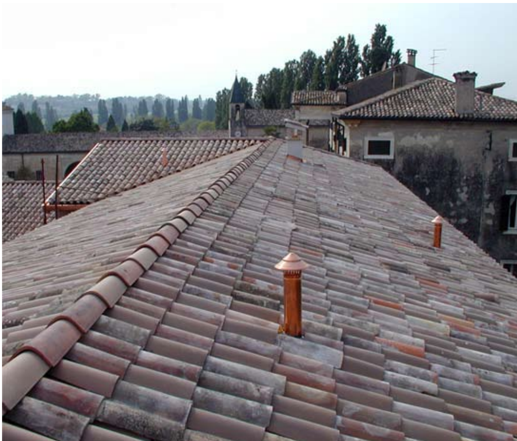
Vista della copertura finita ad intervento ultimato.
