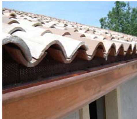
Dettaglio della linea di gronda.
